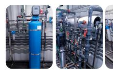
Imagen 3. Tren de pretratamiento de la segunda etapa LIFE Conquer, de izquierda a derecha: resina de intercambio iónico, membrana de nanofiltración y ósmosis inversa.
